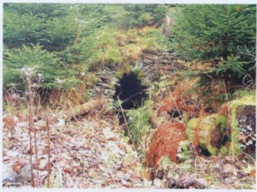
Ústí štoly Wasserlauf (foto: Jan Hloušek)
